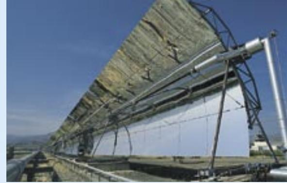
Colector de ranura parabólica de la „Plataforma Solar de Almería“.
